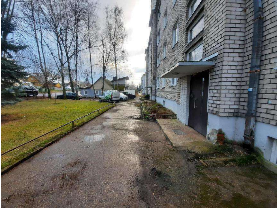
2 pav. Esamos situacijos fotofiksacija
