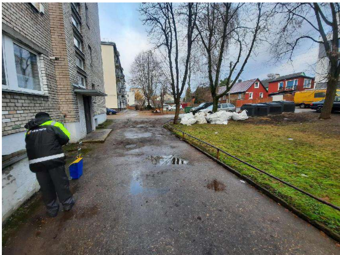
3 pav. Esamos situacijos fotofiksacija
